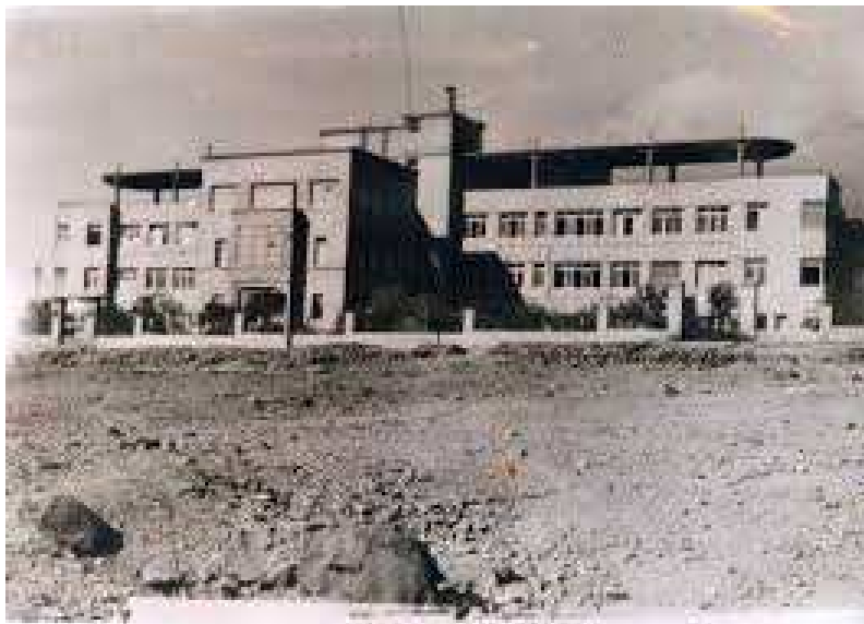
Hospital antiguo de Tocopilla "Marcos Macuada".
