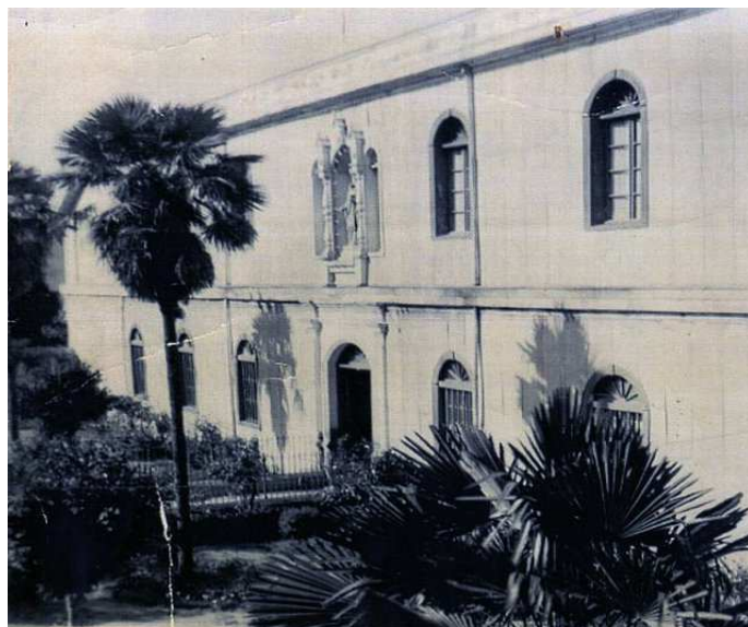
Fachada Antigo Hospital San José de Angol. Gentileza:
